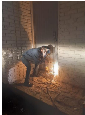
Mantenimiento a las puertas de acceso de las Cabañas Estudiantiles del ITES
