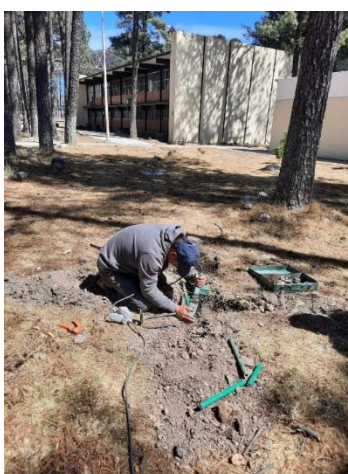
Mantenimiento a la red de suministro de agua para uso doméstico en el ITES
