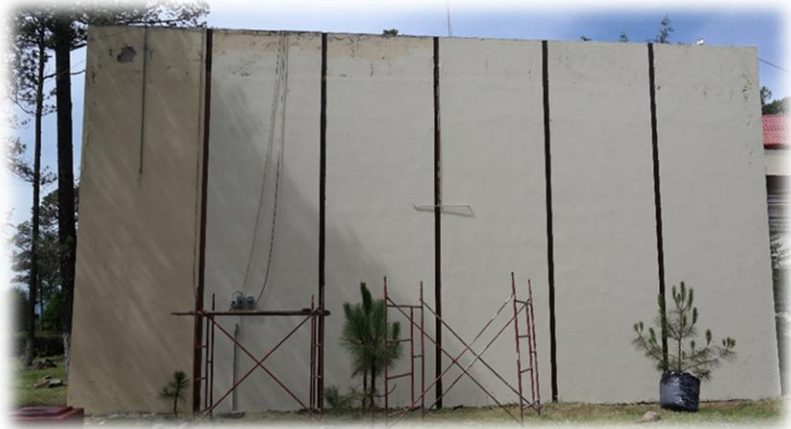
Aplicación de pintura al exterior del edificio de posgrado
