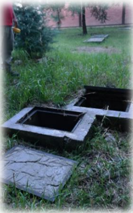
Mantenimiento general a la red de drenaje
