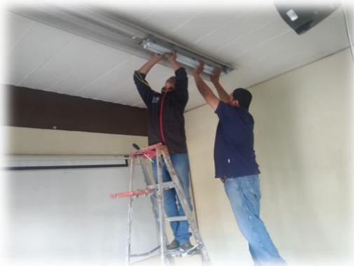
Instalación de lámparas LED en aulas
