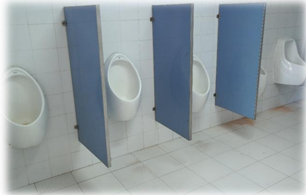
Reacondicionamiento de servicios
